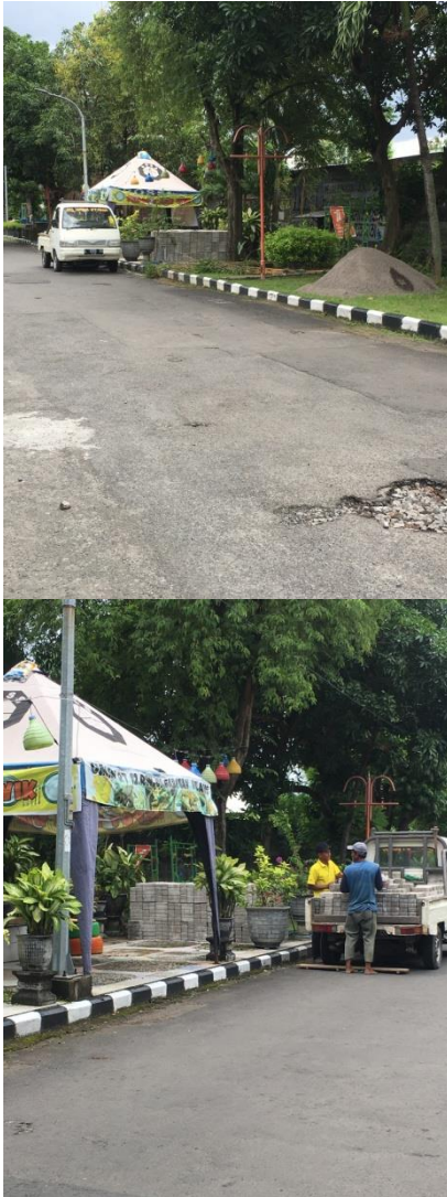
Gambar 4. Kedatangan material pasir dan paving
