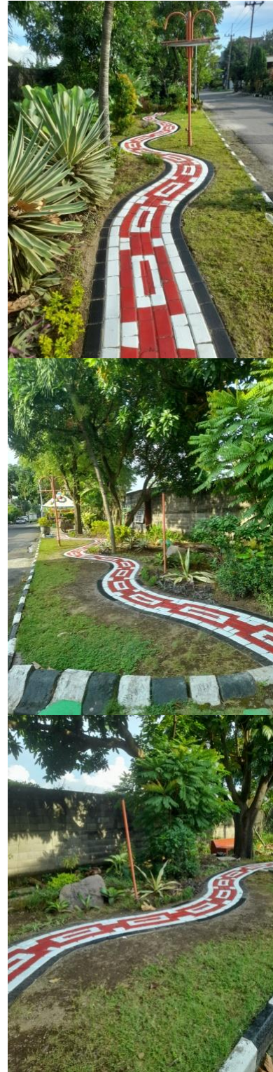
Gambar 7. Hasil pembangunan jogging track sisi Selatan taman RT.002
