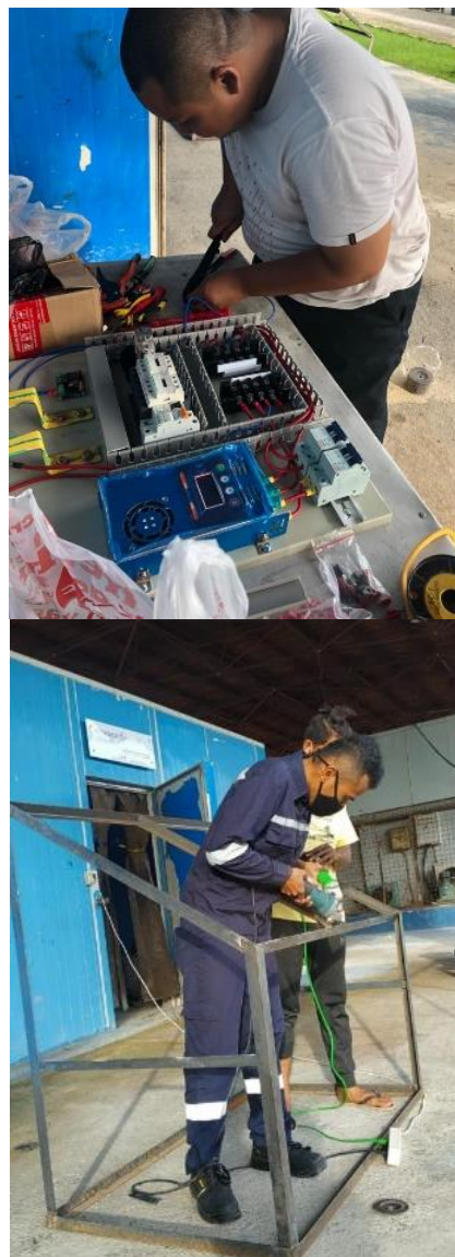
Gambar 1. Instalasi dan pembuatan dudukan panel surya
